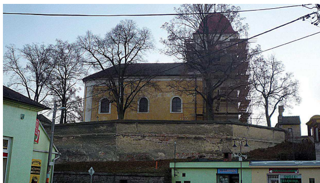
Kostel před opravou.
