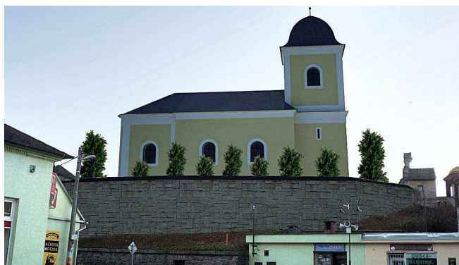
Kostel po opravě.
