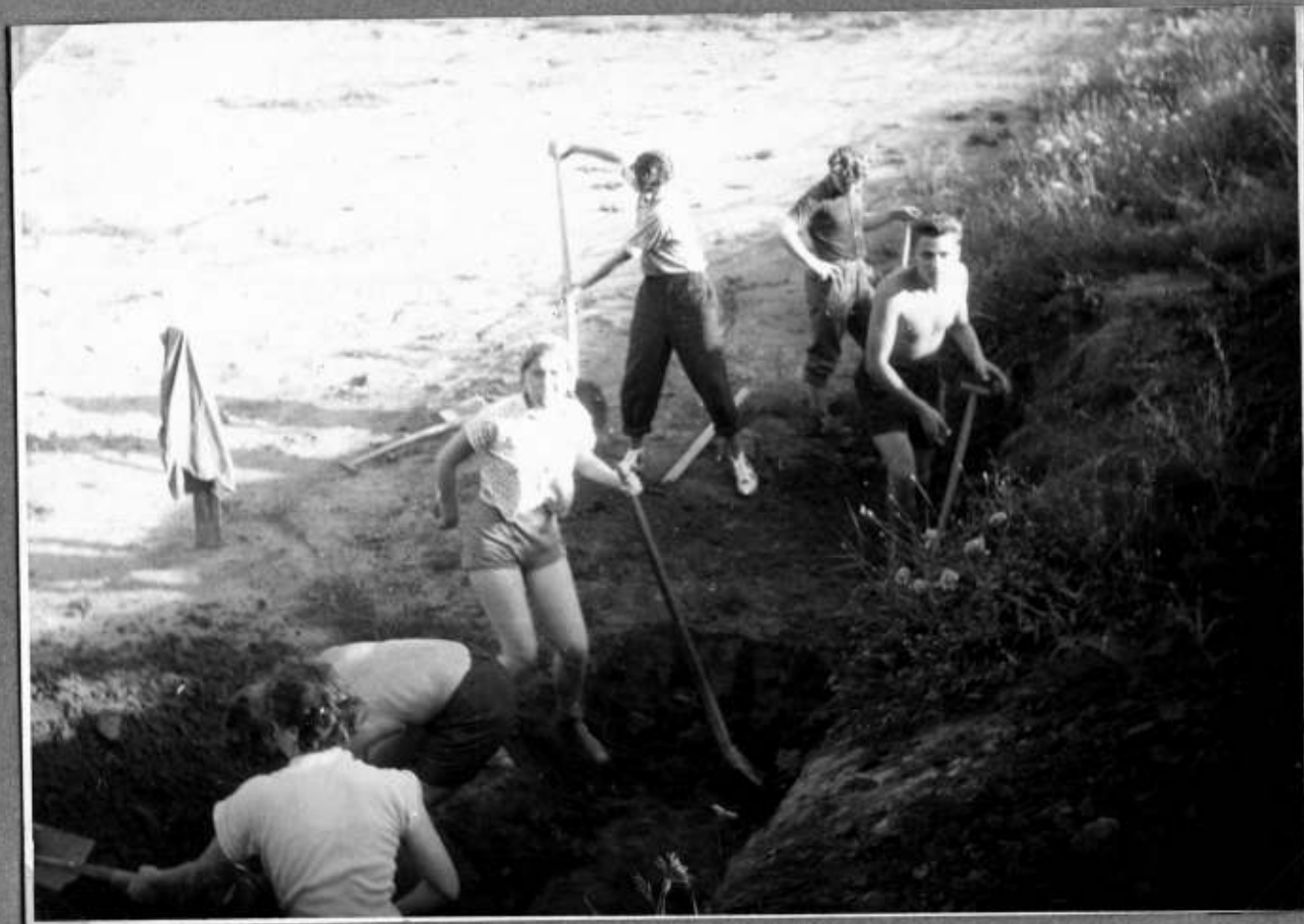
Na jaře r.1954 bylo započato s výkopem základů koupaliště.
