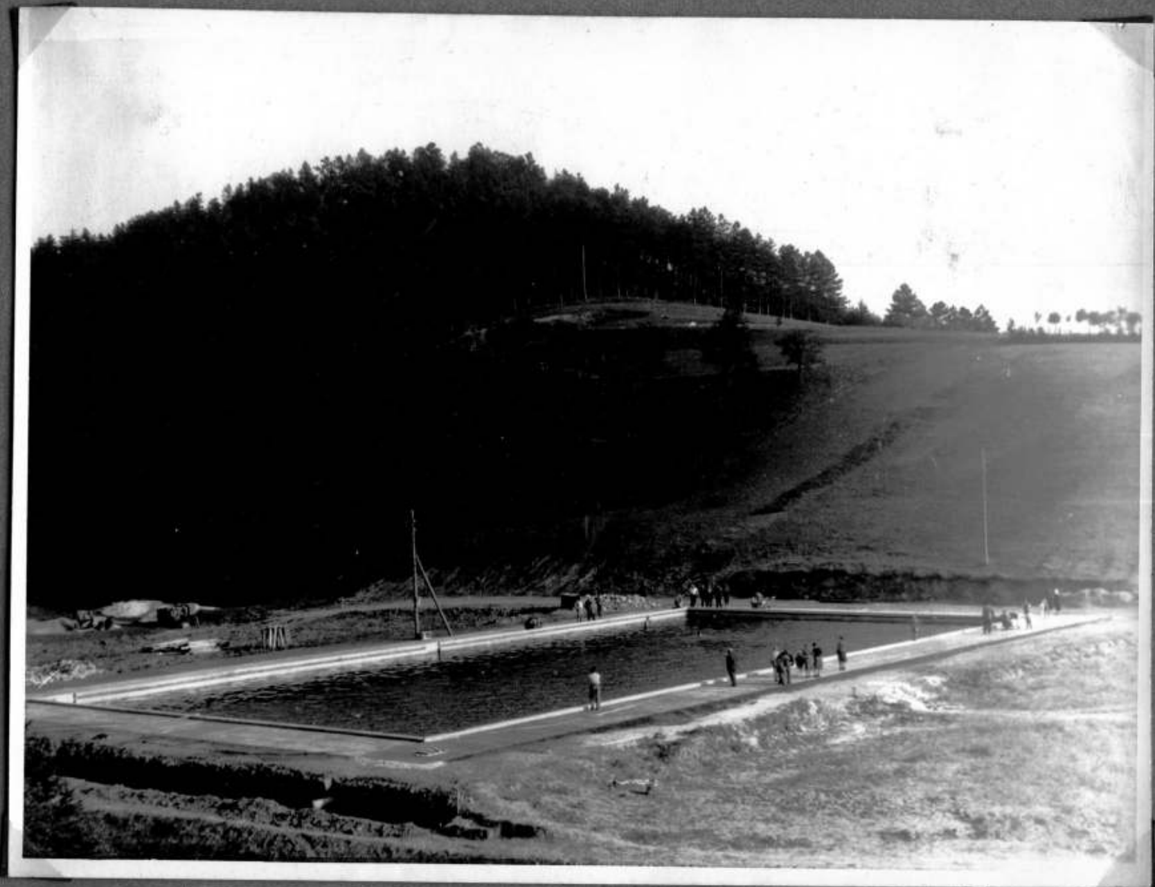
Kolem bazenu byl vybetonován chodník a pod ním byl položen odpad vody z bazenu.
