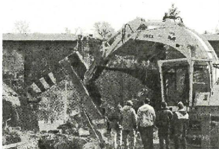
Demolice mostu U labutě 4.3.1998.
