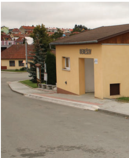
Benešov – chodníky PO realizaci (IROP)
